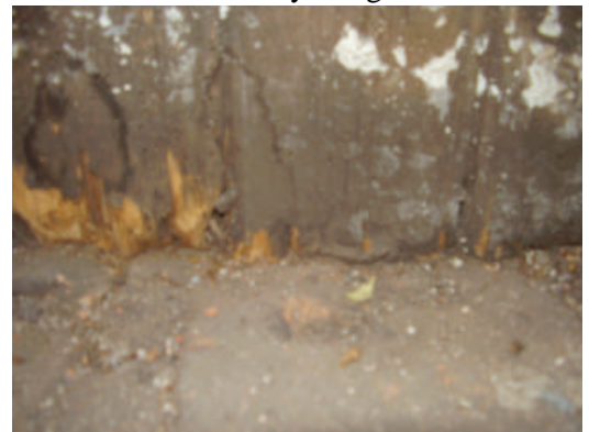
Bild 4. Fuktskadat trä.
